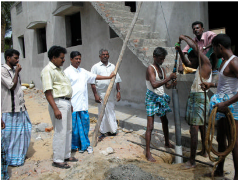
Digging the borewell Erdarbeiten für den Bohrbrunnen
